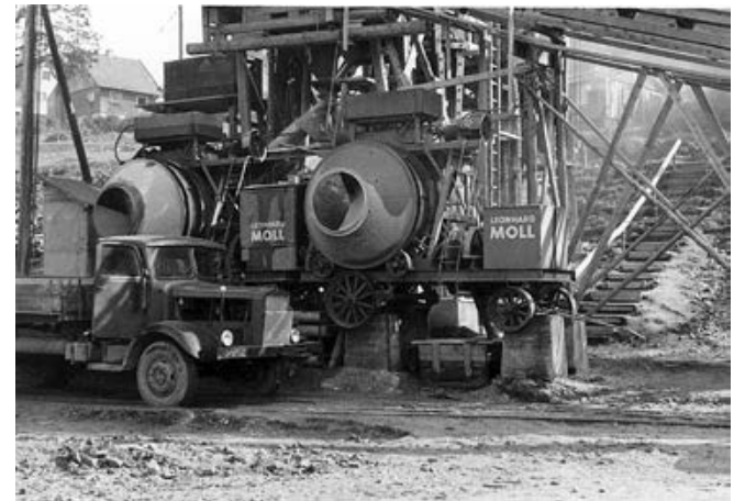
Bild 1: Herstellung des Betons für das Stausee-Kraftwerk Regen in einer Baustellenmischanlage im Jahr 1954; Zu sehen ist die Seite mit den Betonmischern (auf aufgebockten Fahrwerken) und der Beladestraße für Mulden-Fahrzeuge
