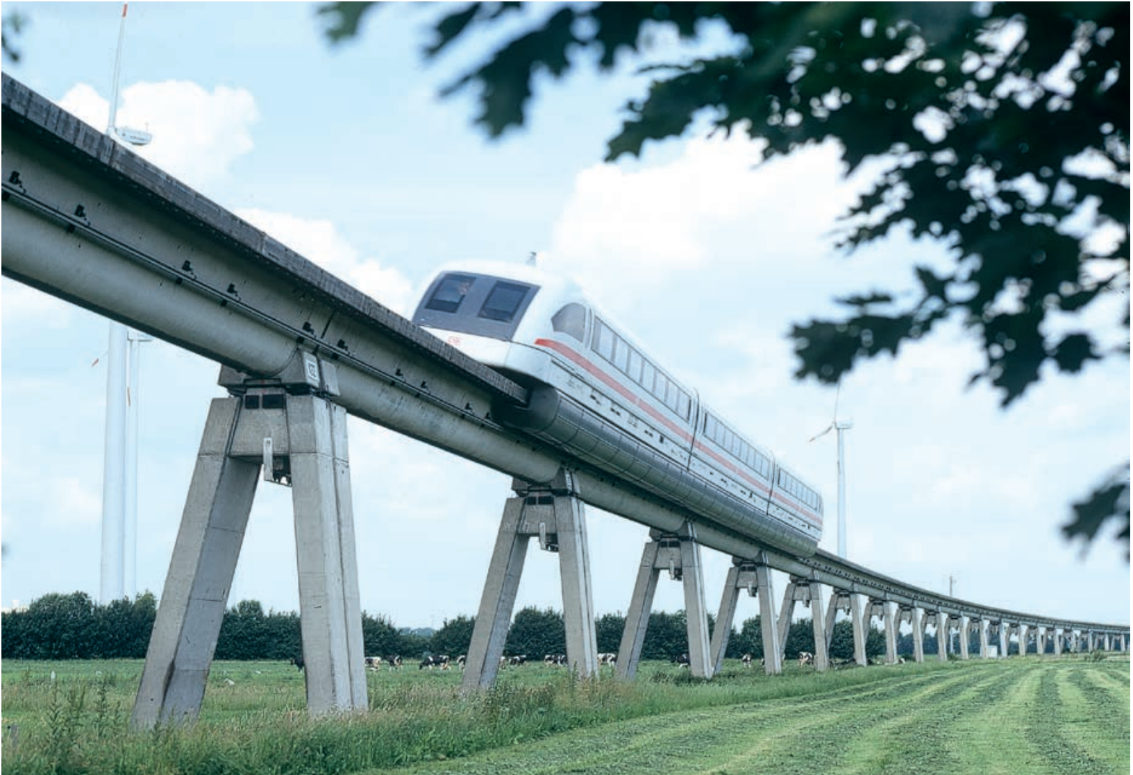
Der Fahrweg der Versuchsstrecke Transrapid im Emsland bewies, dass auch Betonbau in höchster Präzision mit Millimetergenauigkeit möglich ist. Im Jahr 1993 erreichte der Transrapid auf dieser Strecke eine Geschwindigkeit von 450 km /h. Foto: Verlag Bau+Technik
