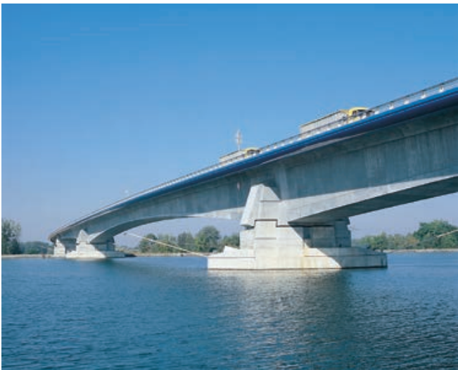
Bild 5: Bei der 2002 fertiggestellten Pierre-Pfämlin-Brücke über den Rhein etwa 5 km südlich von Straßburg ermöglichte die Verwendung von ca. 7.750 m 3 eines Hochleistungsbetons Beton B 65 nach französischer Norm FN P 18-305 (entspricht etwa einem Beton C 70/85 nach DIN EN 206) eine sehr schlanke Form der Hauptbrücke [4].
