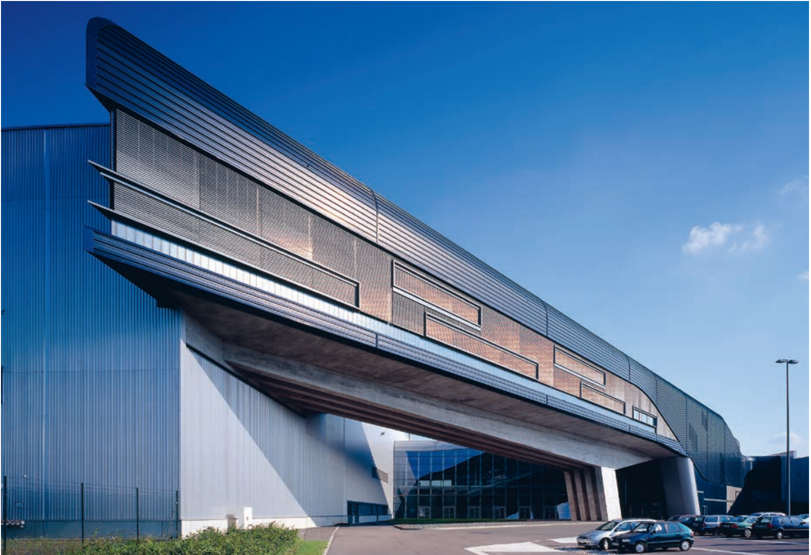
Beim Zentralgebäude des BMW-Werks in Leipzig nach einem Entwurf von Zaha Hadid kam ein selbstverdichtender Beton zum Einsatz. Der dunkelgraue Sichtbeton gibt der Bürolandschaft einen gedämpften Grundton. Foto: BetonBild / Guido Erbring
