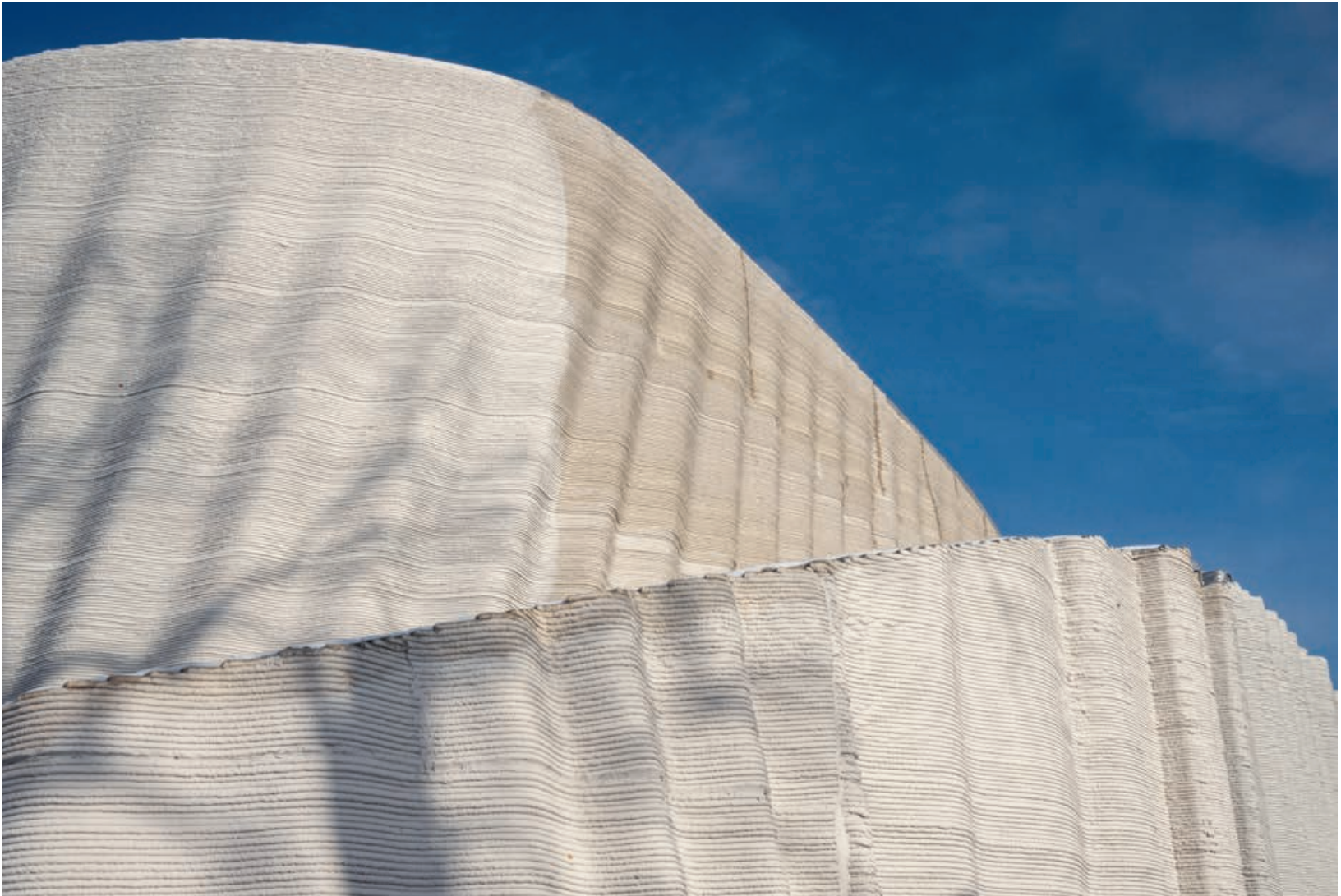
Der 3D-Druck mit Beton ist eines der großen Zukunftsthemen im Betonbau. 2023 baute die Krausgruppe im Baufeld 5 der Konversionsfläche Campbell Heidelberg das mit einer Länge von 54 m und einer Höhe von 9 m derzeit größte 3D-gedruckte Gebäude Europas. Der Entwurf für dieses IT-Serverhotel entstand bei Mense-Korte ingenieure+architekten und SSV Architekten. Foto: Heidelberg Materials AG/Christian Buck
