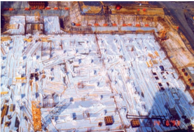
Bild 7: Abdecken der Fundamentplatte (Kraftwerk Schkopau, 1993) mit wärmedämmenden Folien zur Steuerung des Wärmeabflusses
