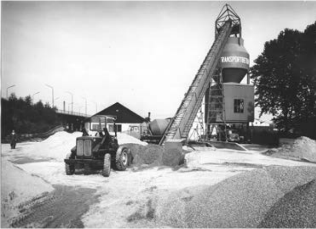
Bild 2: Transportbetonwerk in Düsseldorf im Jahr 1961 mit Mischturm und – im Hintergrund – zwei Fahrmischer; 1971 überflügelte der Transportbeton mit einer Produktion von 50 Mill. m 3 erstmals den Baustellenbeton [1].
