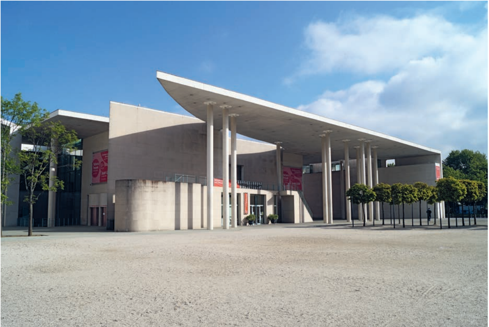
Entworfen wurde das Kunstmuseum Bonn von dem Architektenbüro BJSS – Dietrich Bangert, Bernd Jansen, Stefan Scholz, Axel Schultes und Jürgen Pleuser. Die Stahlbetonkonstruktion mit einem 1200 m 2 großem Vordach auf 13 asymmetrisch gestellten, 12 m hohen Schleuderbetonstützen erhielt den Architekturpreis Beton 1993 und war Veranstaltungsort der VDB-Fachtagung 2014. Foto: Verlag Bau+Technik
