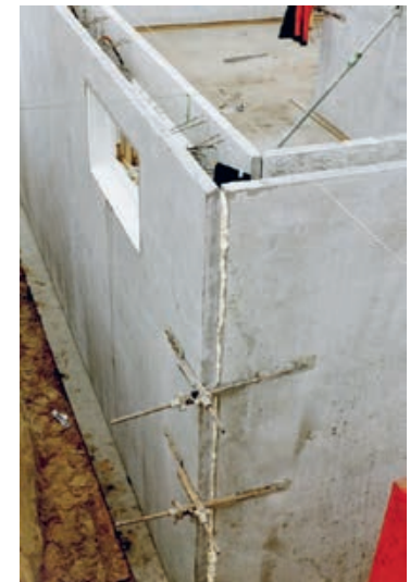
Bild 5: Beispiel für ein wasserundurchlässiges Bauteil – Elementwand für den Keller eines Einfamilienhauses (Foto: Udo Wiens)
