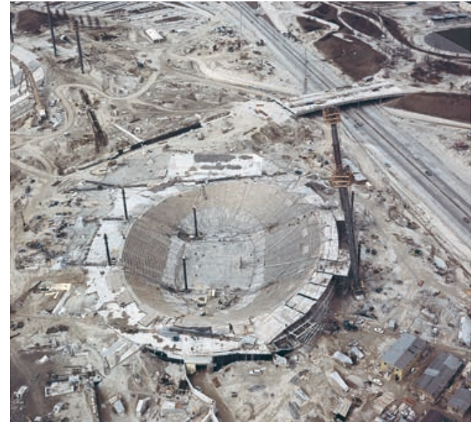
Bild 6: Baustelle „Oberwiesenfeld“ im Jahr 1970 für die Olympischen Spiele in München 1972. Hier bewegte die Olympiabaugesellschaft seit 1969 rund 3,5 Mio. m 3 Erde, verbaute ca. 220.000 m 3 Beton und etwa die vierfache Stahlmenge des Eiffelturms [5]. Alle Fotos: Archiv Verlag Bau+Technik GmbH
