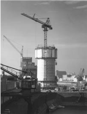
Bild 4: Baustelle des Fernmeldeturms Düsseldorf im Jahr 1979. Der 234,2 m hohe Düsseldorfer Rheinturm ist der erste Turm, der – einschließlich Kanzel – komplett aus Stahlbeton hergestellt wurde. Um die Taktzeiten beim Klettern von maximal 12 bis 14 Stunden einhalten zu können, musste die Druckfestigkeit beim Entschalen mindestens 10 N/mm 2 betragen [3].
