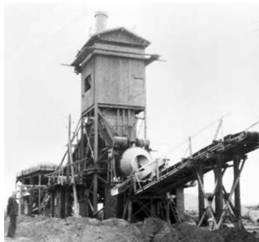
Bild 3: Betonherstellung mit einem Freifallmischer in den 1950er-Jahren
