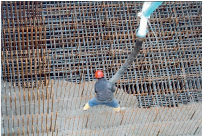
Bild 6: Einbau des Sohlenbetons für die Schleuse Uelzen II
