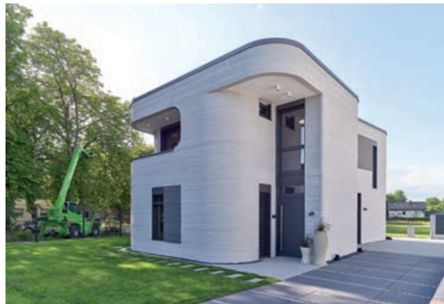
Bild 12: Die Weiterentwicklung der Betonbauweise nimmt kein Ende. Ein Beispiel ist der 3D-Druck von Beton. Das Foto zeigt das erste so gedruckte Haus Deutschlands in Beckum. Foto: PERI 3D Construction
