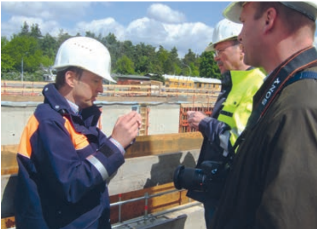
Bild 18: Exkursion der Regionalgruppe Sachsen/Sachsen-Anhalt im Mai 2011 zur Baustelle der Schleuse Wusterwitz
