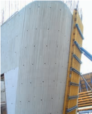
Bild 2: Sichtbetonfläche eines der „Cones“ (PHAENO Science Center in Wolfsburg, Entwurf: Architektengemeinschaft „Phaeno Science Center Wolfsburg“, Zaha Hadid Ltd., London & Mayer Bährle, Lörrach). Foto: E. Heitkamp AG
