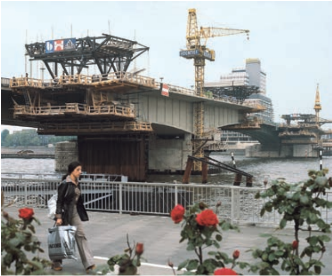
Bild 2: Um den steigenden Anforderungen des Verkehrs gerecht zu werden, musste die Rheinbrücke Köln-Deutz verbreitert werden. Auf verbreiterten Stropfeilern wurde neben der bestehenden Stahlbrücke ein neuer Überbau von 16,30 m Breite in Spannbeton aus Beton B 55 und einem Leichtbeton LB 45 im Freivorbau erstellt. Da der Verkehr auf der vorhandenen Stahlbrücke ungehindert aufrechterhalten werden musste, wurde der neue Bau in einem Abstand von 5,30 m zur endgültigen Lage hergestellt und später verschoben. Das Foto zeigt den Bauzustand im Jahr 1978. Foto: Verlag Bau+Technik GmbH
