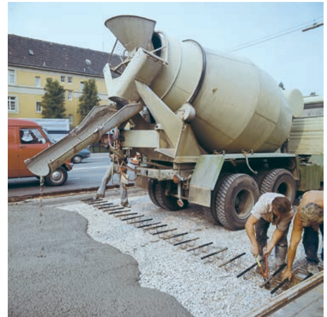
Bild 3: Einbau von Fließbeton im Straßenbau 1977 in Düsseldorf auf der Uerdinger Straße (B7) im Bereich zwischen Danziger Straße (B8) und Kaiserswerther Straße
