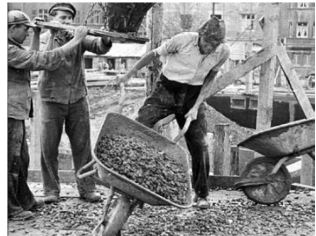
Bild 4: Betonverarbeitung in den 1950er-Jahren
