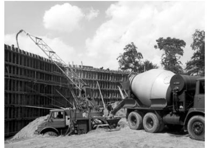
Bild 3: Die zunehmende Lieferung des Betons aus Transportbetonwerken, die Förderung mit Betonpumpen – hier beim Bau einer Brücke über die Itter bei Hilden im Jahr 1967 – und neue Betonausgangsstoffe stellten die Beton-technologen in den 1960er-Jahren vor neue Herausforderungen.
